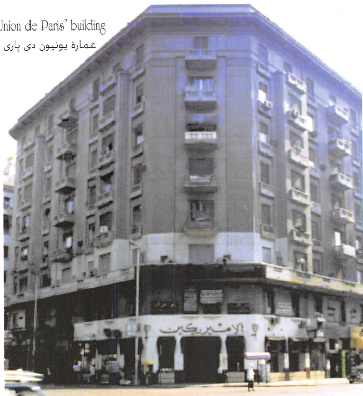
عمارة جروپي "Groppi" building
